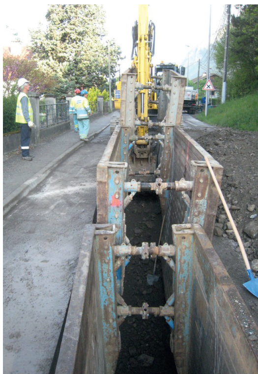
Travaux de réhabilitation de réseaux d'eaux usées
