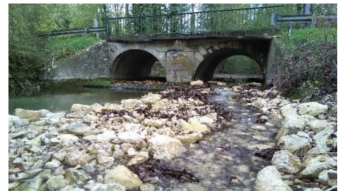
Figure 2: restauration de la continuité écologique sur l'Airain, commune de Vornay (©SIAB3A)
