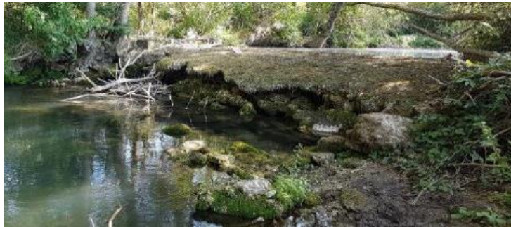
Effacement du barrage D et stabilisation des profils en amont de Bourges
