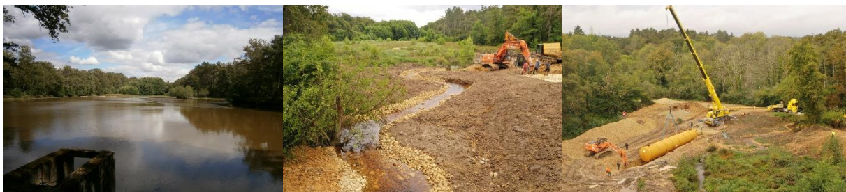
Figure 3: plan d'eau des Noues avant puis pendant les travaux de restauration et pose d'une cuve de 120m 3 pour la lutte incendie.
